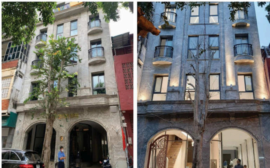
CÔNG TRÌNH NHÀ Ở KẾT HỢP VĂN PHÒNG SỐ 09 NGUYỄN BÌNH KHIÊM
